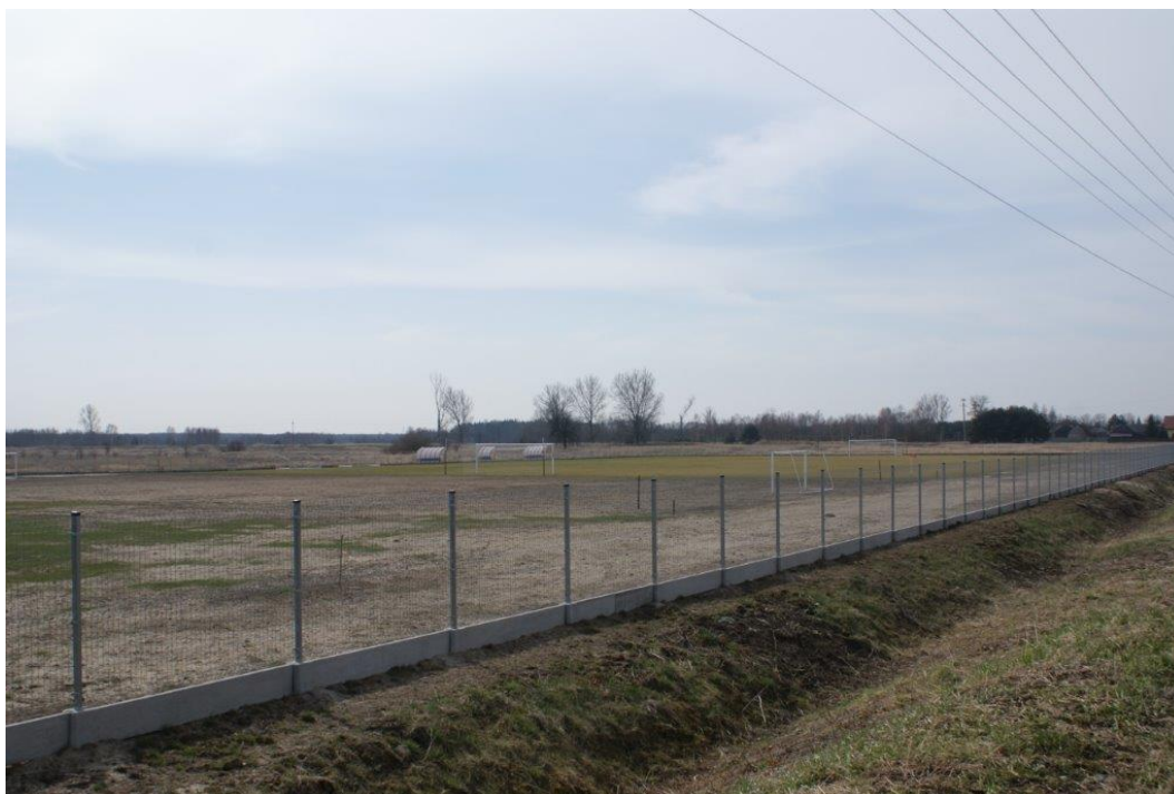
Fot. Archiwum Urzędu Gminy, ogrodzenie boiska sportowego w Gidlach
